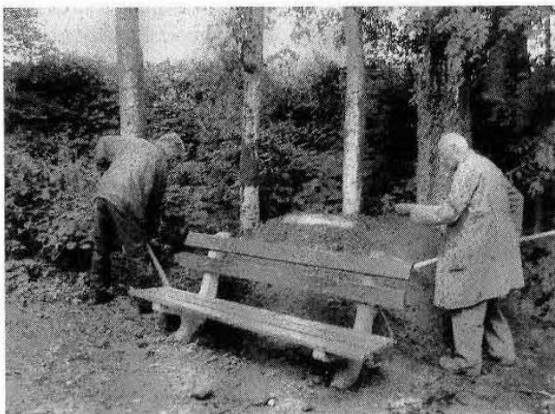
De sokkel ligt op zijn plaats.
